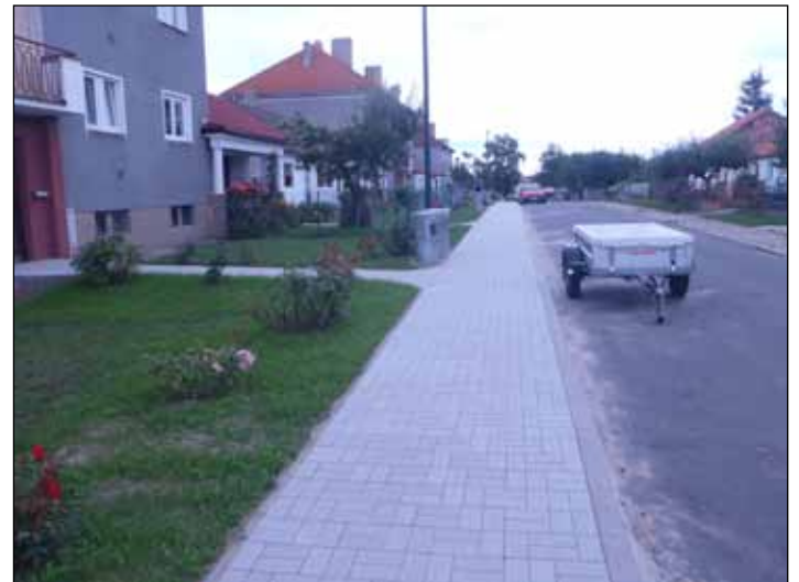
V souvislosti s opravami rozvodných sítí provedlo město během letních prázdnin rozsáhlou rekonstrukci chodníků v lokalitě na „Koreji“.
